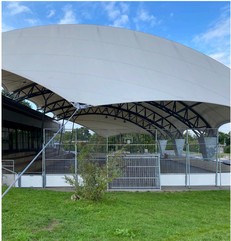
Abbildung 10: Freilufthalle mit Skateranlage an der KGS Neustadt.
