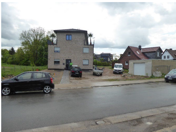
Abb. 1: Bebauung an der Suttorfer Str. (Nrn. 22 - 20)
